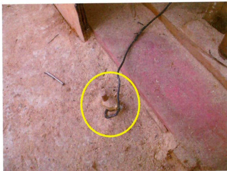
Figura 26 – Detalhe do aterramento.
