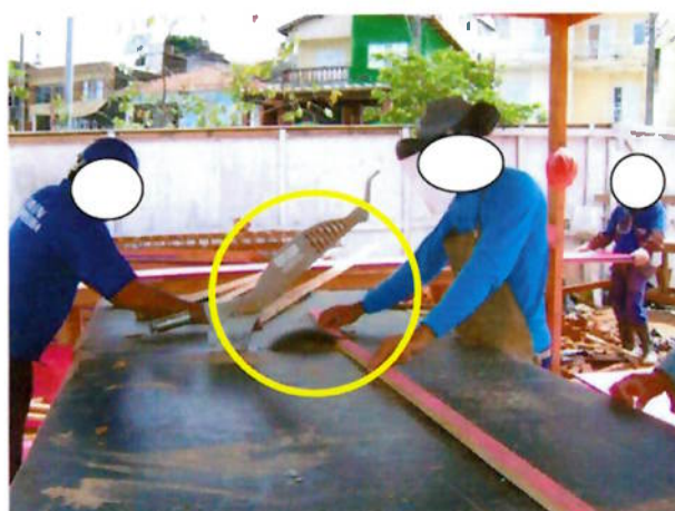
Figura 21 – Corte da peça sem proteção.
